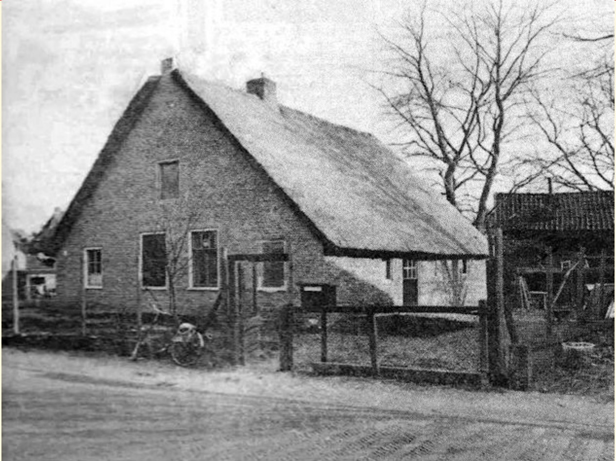
Plaggenweg 5, voor de sloop
